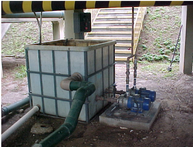
Figura 3 – Vista parcial do sistema de reuso de água
