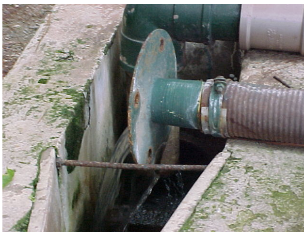
Figura 4 – Vista da saída do efluente tratado
